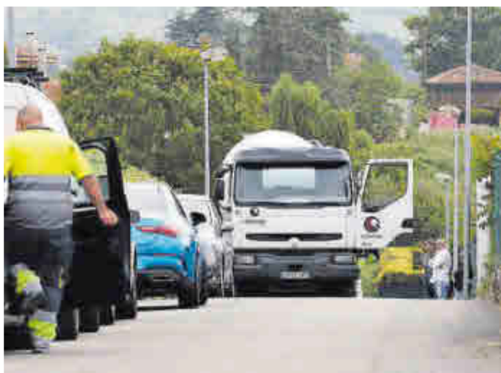
El camión hormigonera utilizado en los trabajos.
